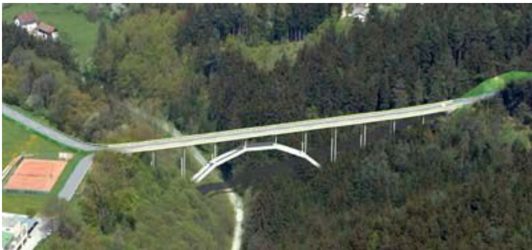
3. ábra: Az ausztriai Völkermarktban, a Mühlgraben (Malomárok) felett, részben szálerősítésű ultra nagy szilárdságú betonból épült közúti híd Forrás: http://www.arching.at
