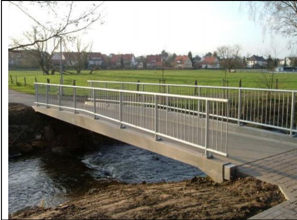
1. ábra: Gyalogos és kerékpáros híd a Nieste folyó felett, Kasselben, ultra nagy szilárdságú előregyártott feszített vasbetonelemből. Fesztávolság: 12 m, lemezvastagság: 10 cm, szegélymagasság: 40 cm. A 12 tonnás elemet autódaruval emelték a helyére. Forrás: Schmidt, M. – Fehling, E., 2006
