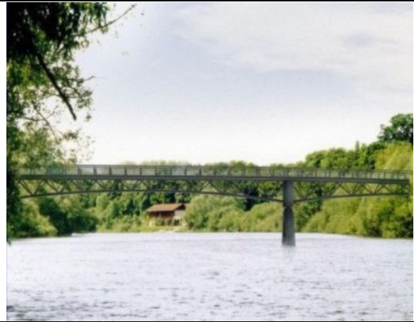
2. ábra: A Fulda folyó felett átívelő, 140 m hosszú Gärtner téri híd Kasselben, ultra nagy szilárdságú, szálerősítésű betonból készített, keresztirányban előfeszített, 5 m széles és 8,5 cm vastag pályalemezzel, és a pályalemezt alátámasztó, hosszirányban utófeszített övvel. Forrás: Schmidt, M. – Fehling, E., 2006
