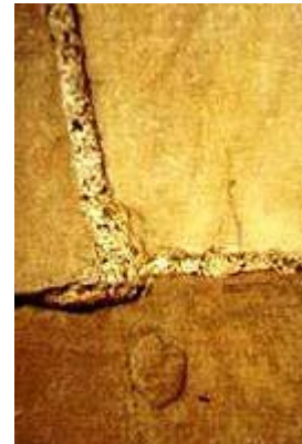
6. fénykép. Az 5. fényképen láthatóhoz hasonló elrendezésű falazat a frank építési periódusból
