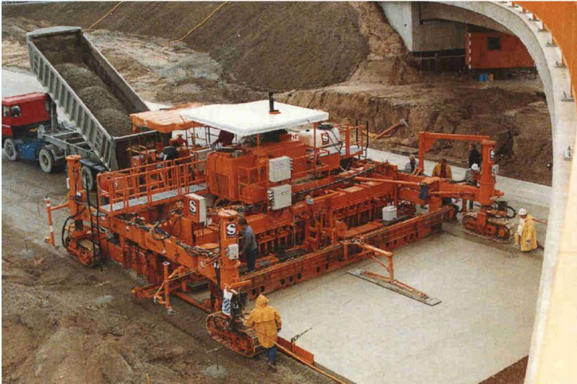
4. ábra: Csúszózsalus betonozás
